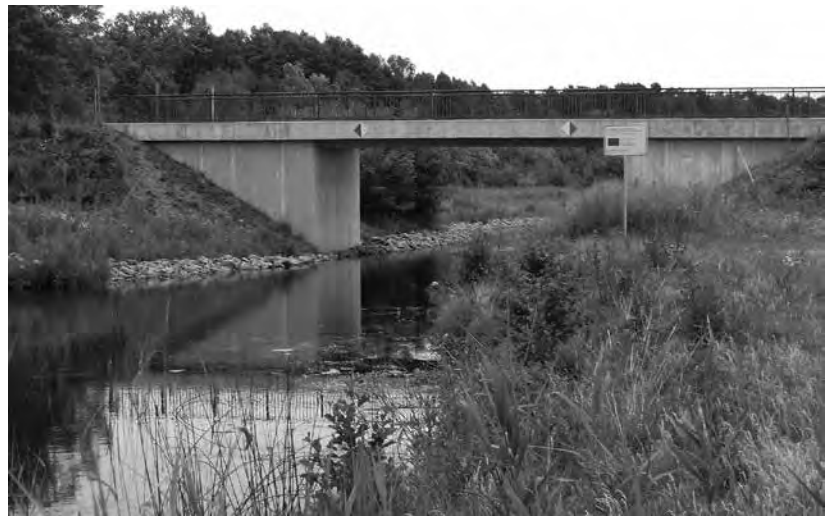
Brücke über den Neubau des Werbellinkanals. Foto: hjm
